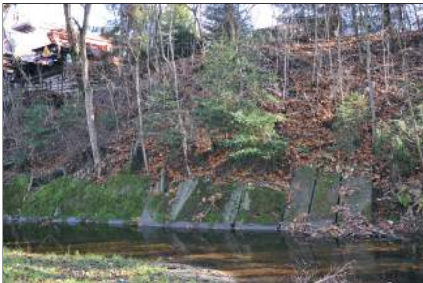
Fot. 6. Umocnienia brzegów koryta Raby; A – mur zabezpieczający nasyp kolejowy, odc. 2, B, C – mury i umocnienia w strefach bliskiej zabudowy, odc. 3
