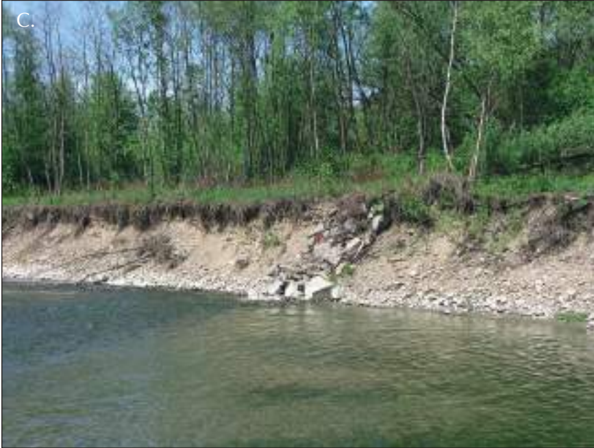
Fot. 18. Koryto Skawy w 2012 roku, A, B – koryto kręte z naprzemiennie występującymi łaciami bocznymi i podcięciami, C – zniszczona regulacja w korycie (ostatnia widoczna)
