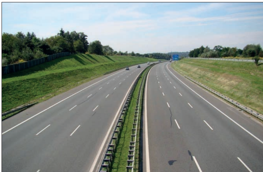
Ryc. 3. Obsiany trawą pas rozdzielający jezdnie oraz roślinność na zboczach wkopu po obydwu stronach autostrady – widok z wiaduktu na ul. Podgórci na zachód, lato 2011 (fot. K. Wiercioch)
