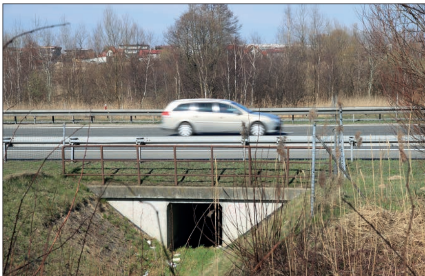
Ryc. 4. Przepust wodny pod autostradą, widok na północ, wiosna 2014. W tle Piaski Wielkie przy ul. Cechowej i Piaski Nowe (fot. W. Ziaja)
