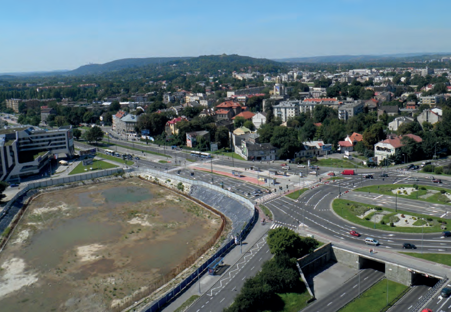
Plac budowy Centrum Kongresowego przy Rondzie Grunwaldzkim (2011)
