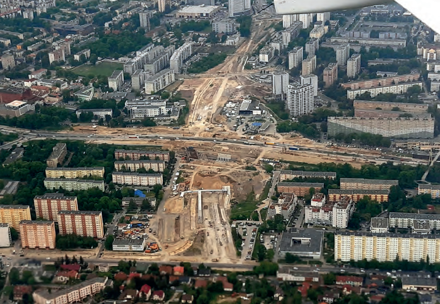
Budowa linii tramwajowej i dróg w rejonie Opolskiej i Pachońskiego
