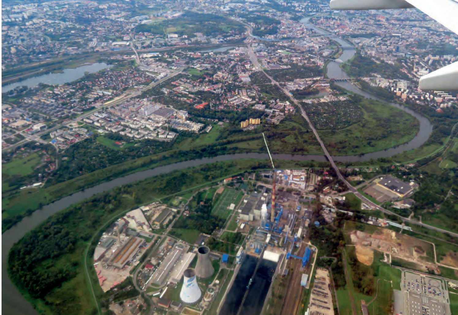
Elektrociepłownia w Łęgu nad Wisłą
