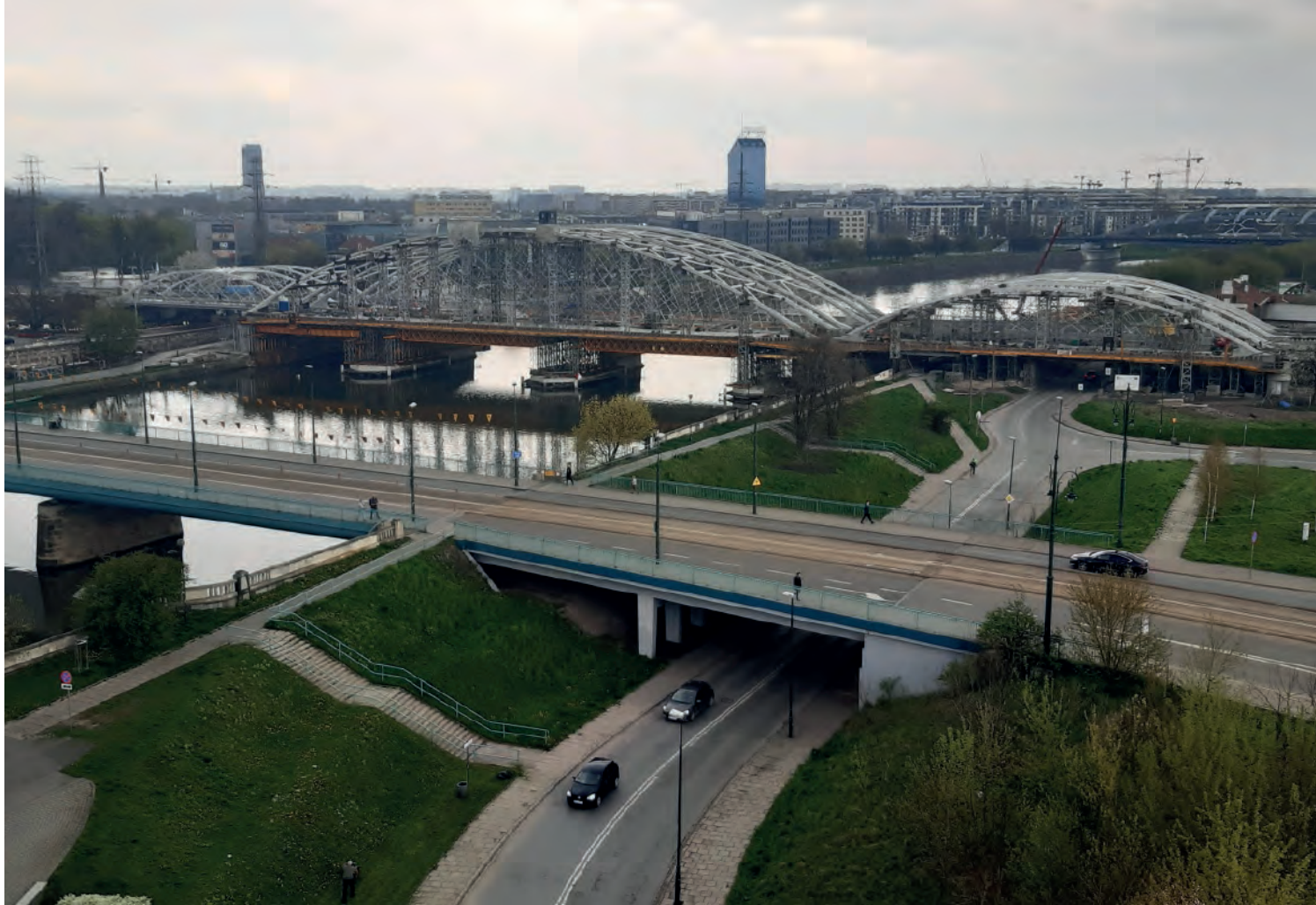
Mosty drogowy i kolejowy na Wiśle
