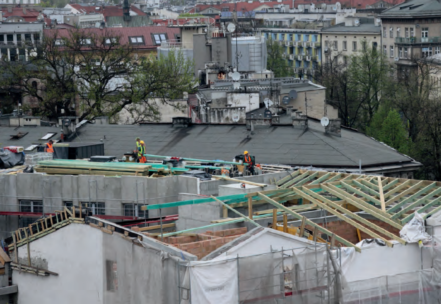
Budowa hotelu przy Placu Kossaka (2018)
