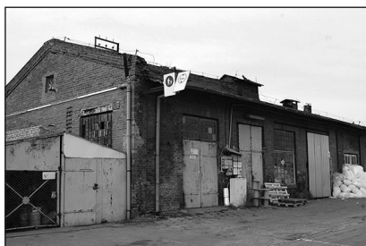
Fot. 2. Budynek po dawnej hali produkcyjnej (Fot. M. Balcerak.)
