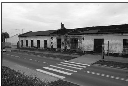
Fot. 1. Budynek po dawnej hali produkcyjnej (Fot. M. Balcerak.)
